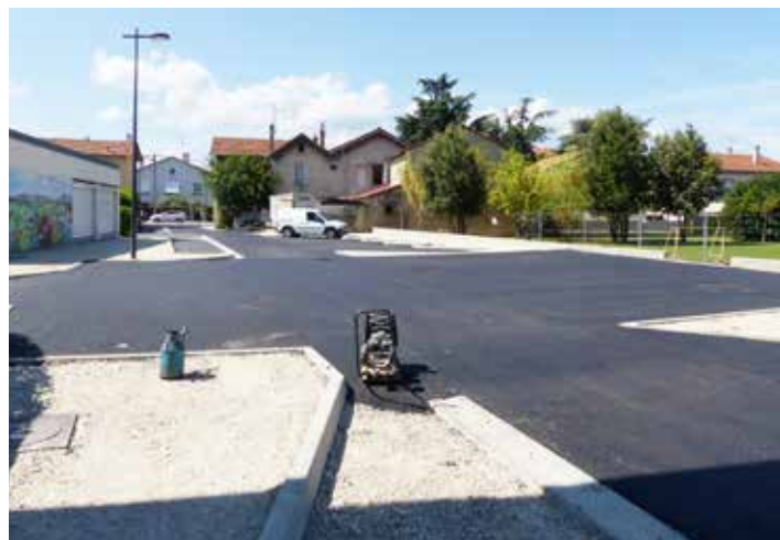
Rue Joliot Curie, réfection de la chaussée et des trottoirs et création de places de stationnement supplémentaires
