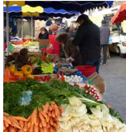
Remplacement des bornes électriques du marché
