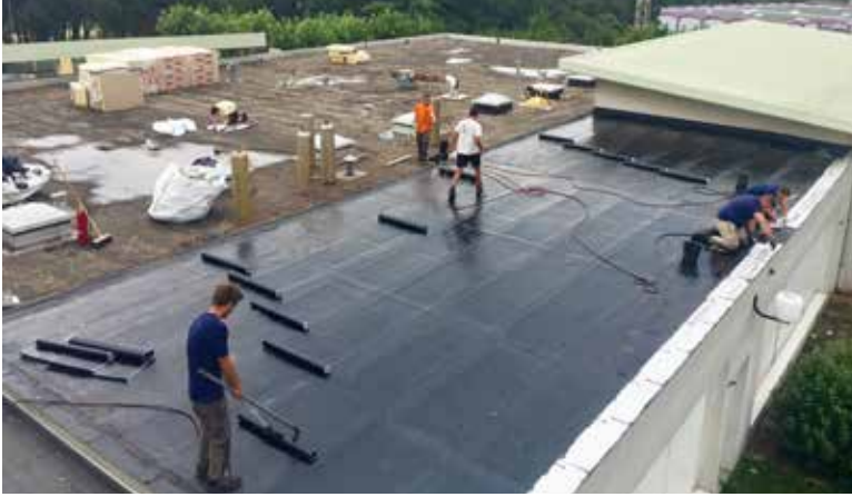
Reprise de l'étanchéité et isolation de la toiture du groupe scolaire Voltaire,
